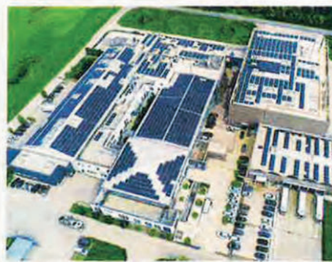
Die Photovoltaikanlage auf dem Betriebsgelände in Enns. In Summe produziert SALESIANER mit allen Anlagen ca. 5 Mio. kWh Strom pro Jahr.
